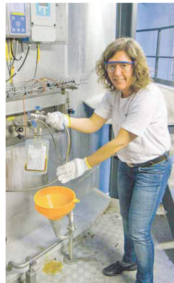
Laborant Laila Bleeg Smidt, Vitalys I/S, udtager prøve af ferment i en Keofit aseptisk prøveudtagningspose.
